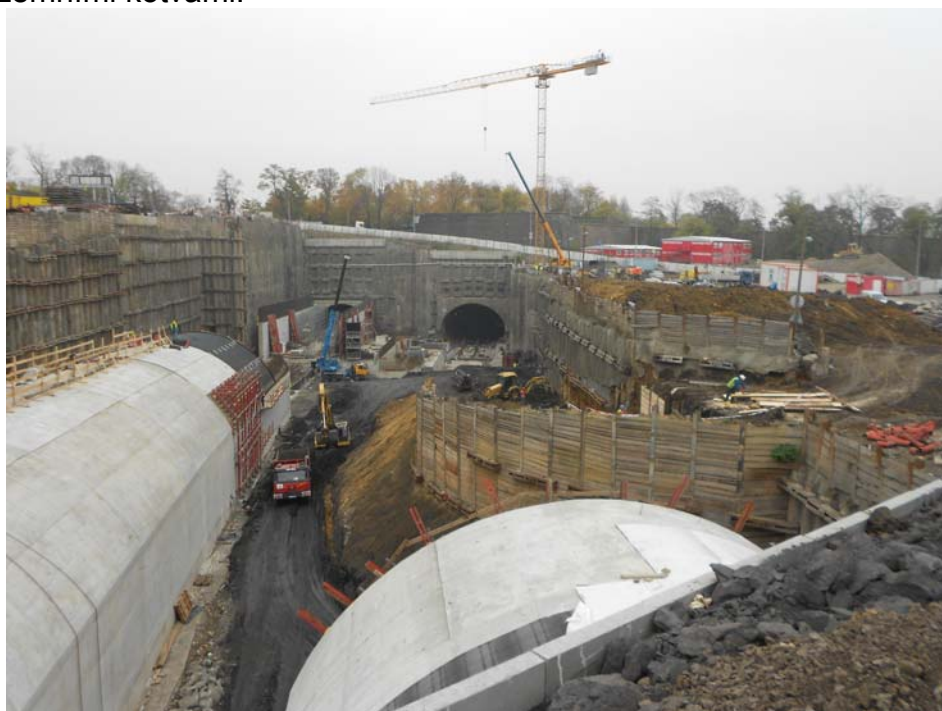
Obrázek č.2 – pohled na stavební jámu 3.fáze
